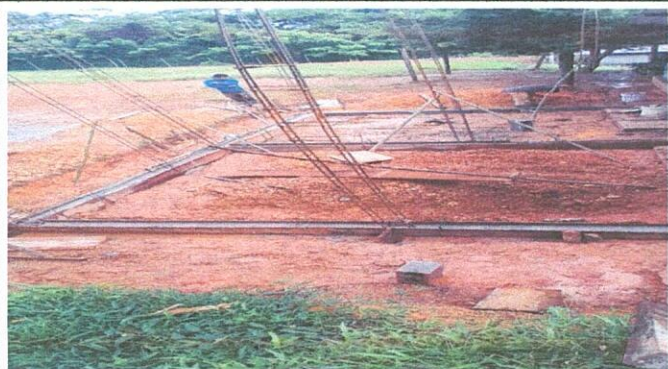
Foto1: Mejoramiento de cimiento corrido
