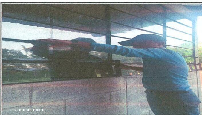
Foto 4: Mejoramiento de ventanas
