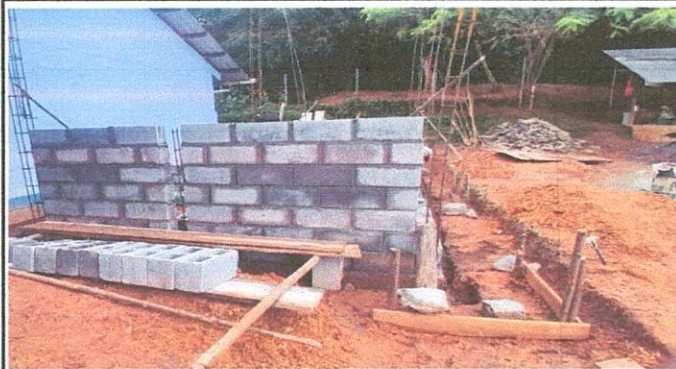
Foto 2: Mejoramiento de pared de block
