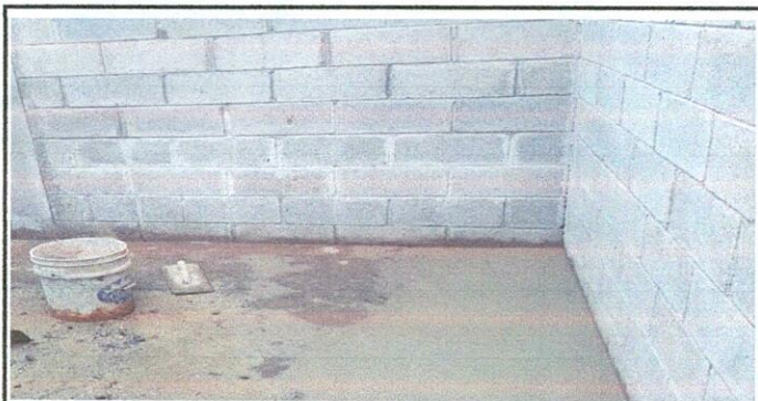
Foto 5: Mejoramiento torta de piso
