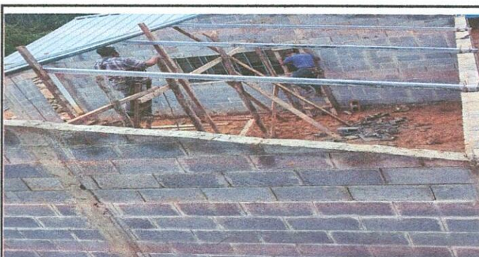
Foto 6: Mejoramiento estructura de metal con techo
